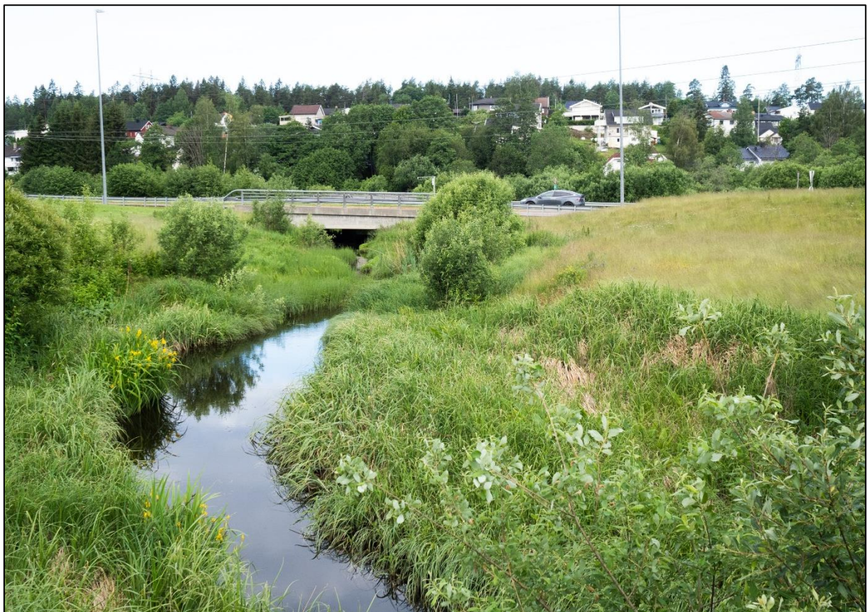
Åpen bekk under veikulvert. Fotograf: Åse Holte, Asplan Viak
